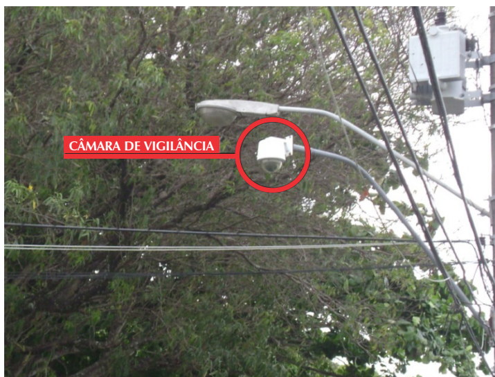
FIGURA 2 - CÂMARA DE VIGILÂNCIA INTERNA - CONDOMÍNIO ALDEBARAN BETA - MUNICÍPIO DE MACEIÓ - ESTADO DE ALAGOAS
